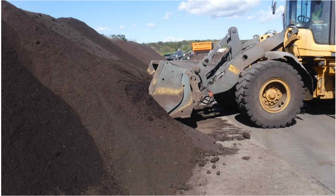
Fotos 3 und 4: Probenahmeschnitt Lader
